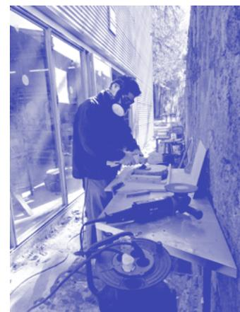
Primeiro recorre-se a uma polidora equipada com um prato de nylon de 180mm e com um disco de lixa de grão 40 para madeira, também de 180mm. De seguida passa-se para uma lixadora de 125mm equipada com prato de velcro rígido e com um disco de lixa de grão 60, também de 125mm.
